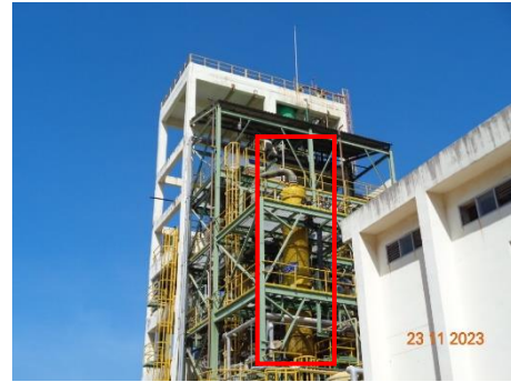
ภาพที่ 2.2-2 Chlorine Absorption Unit
