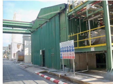
ภาพที่ 2.2-8 การติดตั้ง Noise Hood
