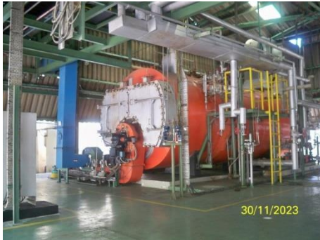
ภาพที่ 2.2-7 การใช้ก๊าซไฮโดรเจนเป็นเชื้อเพลิง สำหรับหม้อผลิตไอน้ำ
