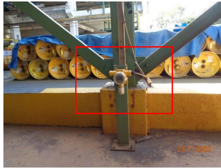
ภาพที่ 2.2-36 Chlorine Gas Detector บริเวณถังเก็บคลอรีนเหลว
