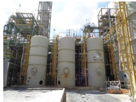
ภาพที่ 2.2-47 ถังเก็บ Allyl Chlorine 40 ตัน
