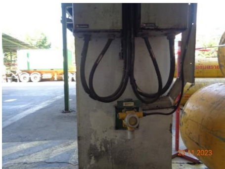
ภาพที่ 2.2-38 สัญญาณเตือน (Alarm) บริเวณ Chlorine Compressor
