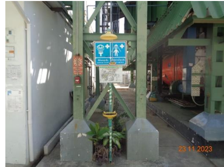
ภาพที่ 2.2-28 ฝักบัวฉุกเฉินและอ่างล้างตาบริเวณพื้นที่โรงงาน
