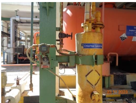
ภาพที่ 2.2-33 Interlock Temp Low Trip บริเวณหน่วยผลิตคลอรีนเหลว
