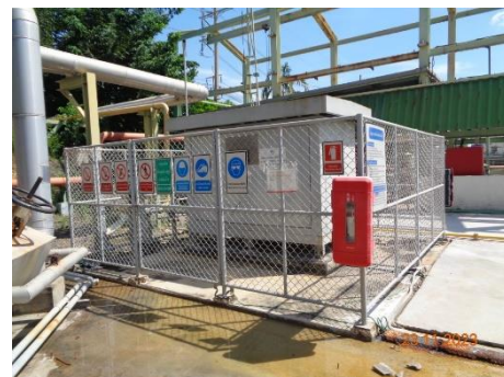
ภาพที่ 2.2-6 การใช้ก๊าซธรรมชาติเป็นเชื้อเพลิง สำหรับ Incinerator
