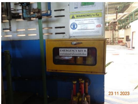
ภาพที่ 2.2-42 ชุดอุปกรณ์ Emergency Kit บริเวณถังเก็บคลอรีนเหลว
