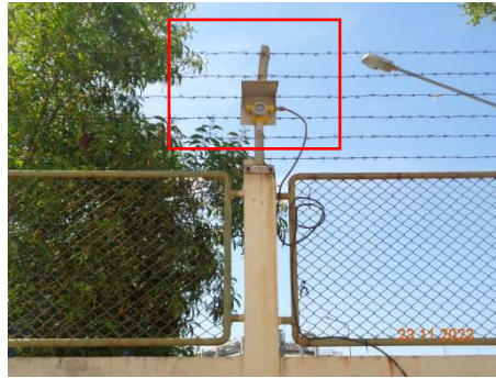
ภาพที่ 2.2-45 Cl 2 Gas Detector รอบรั้วโรงงาน
