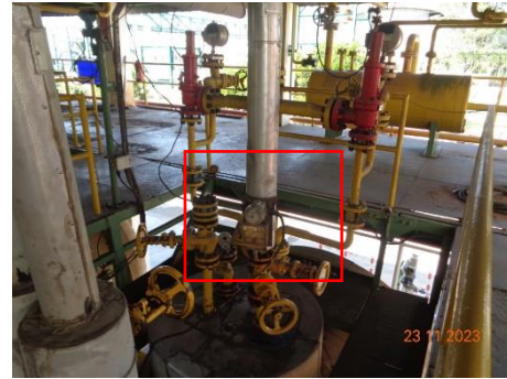
ภาพที่ 2.2-41 เครื่องวัดอุณหภูมิ บริเวณถังเก็บคลอรีนเหลว
