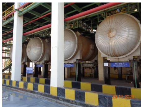
ภาพที่ 2.2-35 การติดตั้งม่านน้ำ คั่นคอนกรีตและพื้นที่จัดเก็บถังเก็บคลอรีนเหลว
