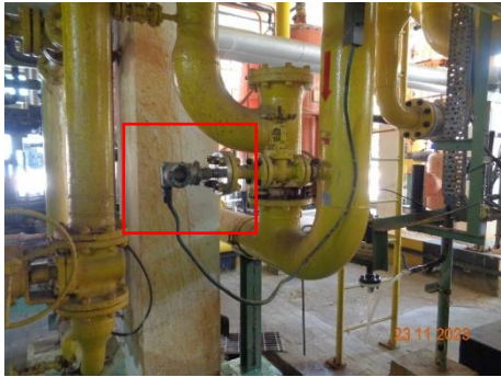
ภาพที่ 2.2-40 Pressure Indicator & Alarm บริเวณถังเก็บคลอรีนเหลว
