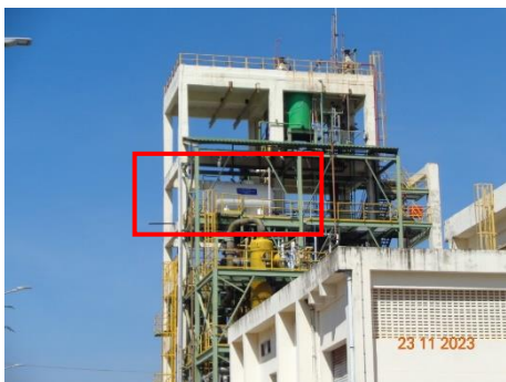
ภาพที่ 2.2-3 Head Tank บรรจุสารละลาย NaOH บริเวณ Chlorine Absorption Unit
