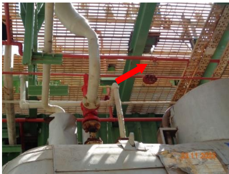
ภาพที่ 2.2-46 ระบบสเปรย์อัตโนมัติ (Sprinkler) บริเวณพื้นที่เก็บโฟรโฟลีน
