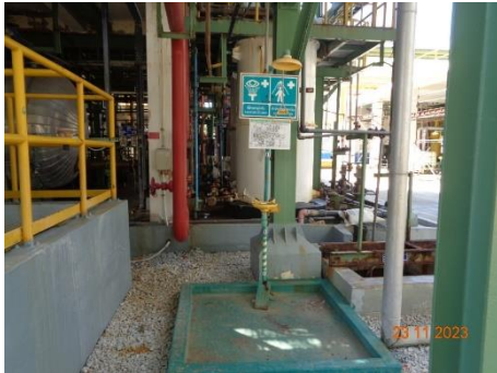
ภาพที่ 2.2-28 ฝักบัวฉุกเฉินและอ่างล้างตาบริเวณพื้นที่โรงงาน
