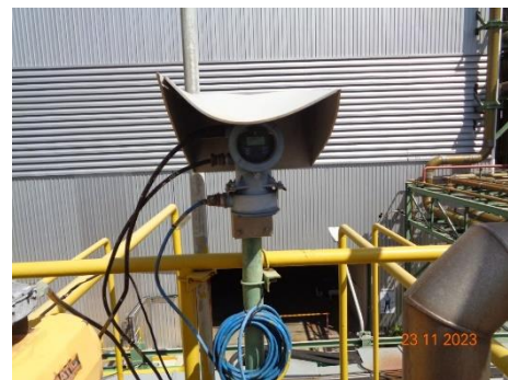
ภาพที่ 2.2-34 Mass Flow Meter ที่ขาออก จากหน่วยผลิตคลอรีนเหลว
